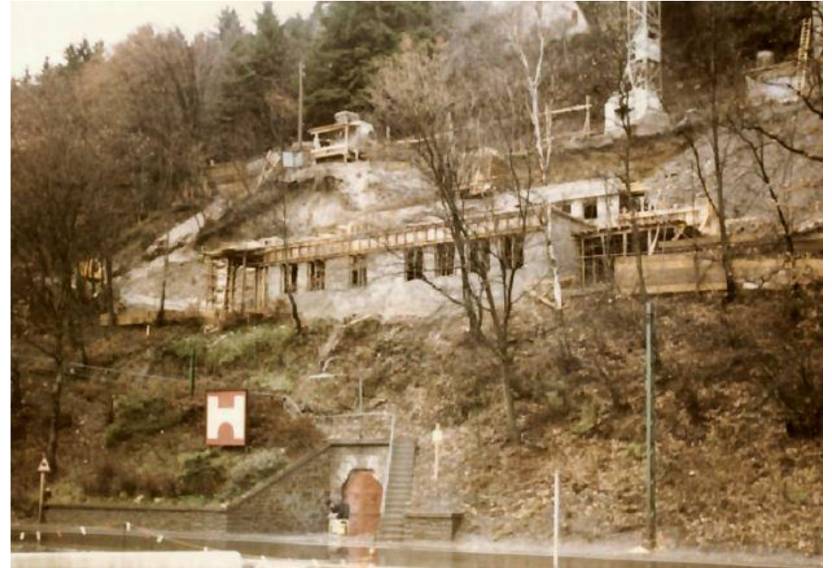
Sanierung und Erweiterung der Grube Pützhorn durch den Wasserverband (1963-1966)
