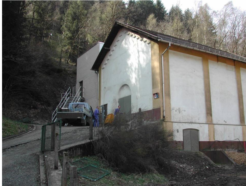
Alte Aufbereitungsanlage Vereinigte Henriette, dahinter bereits der Neubau
