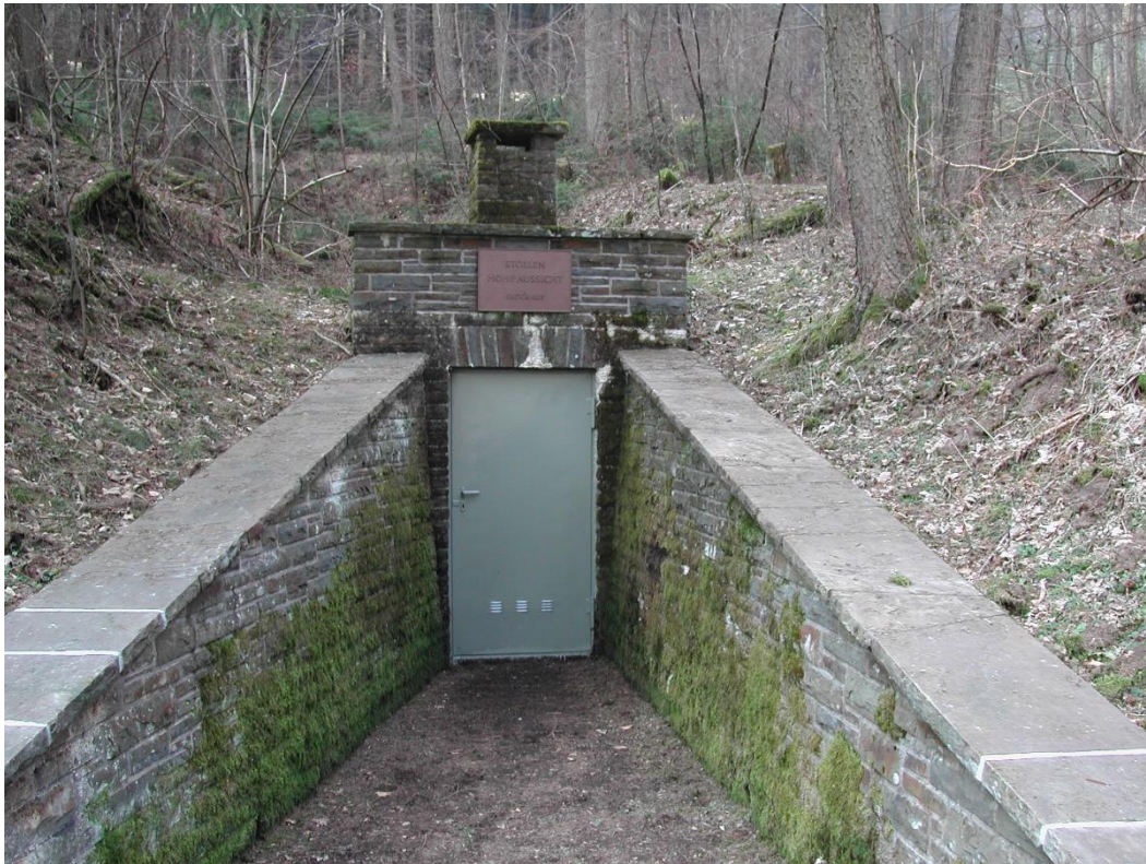
Bergwerk Vereinigte Henriette, Stollenportal Hohe Aussicht vor der Sanierung
