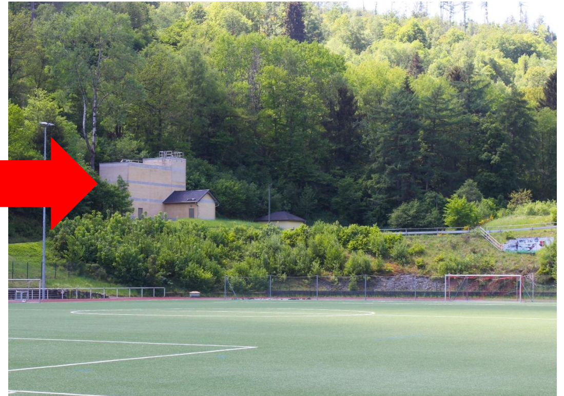
Grube Vereinigte Henriette, Aufbereitungsanlage (2024)
