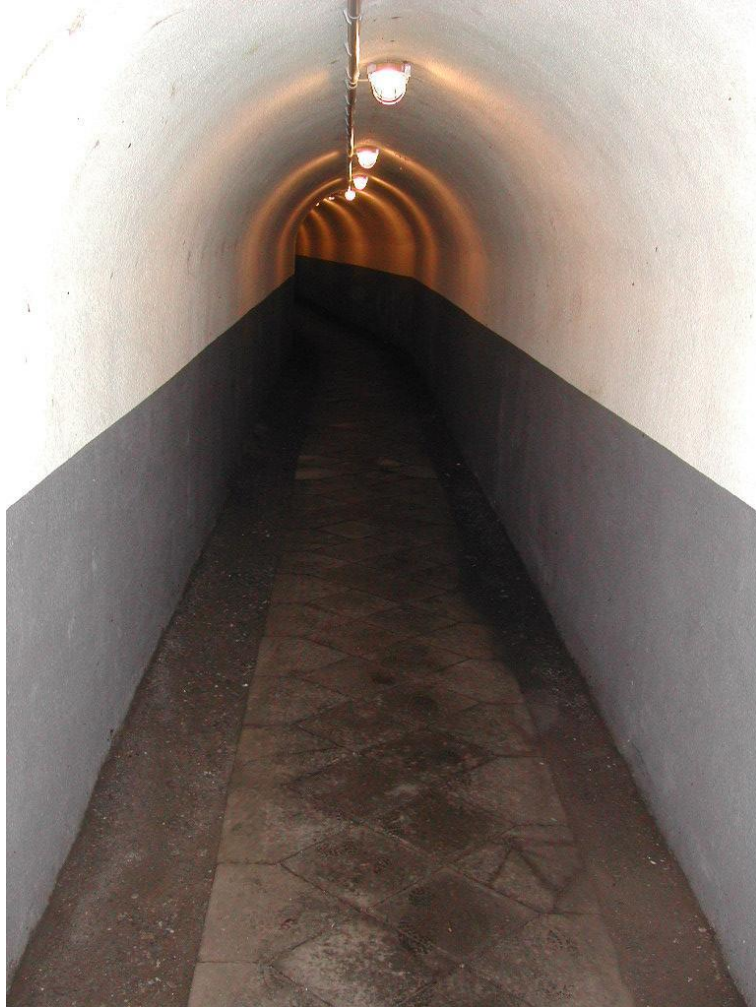
Straßenstollen (unterer Stollen)
