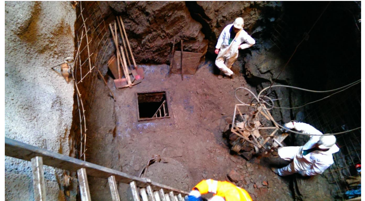
Sicherung des Schachtkopfes (Maschinenschacht) (2014)
