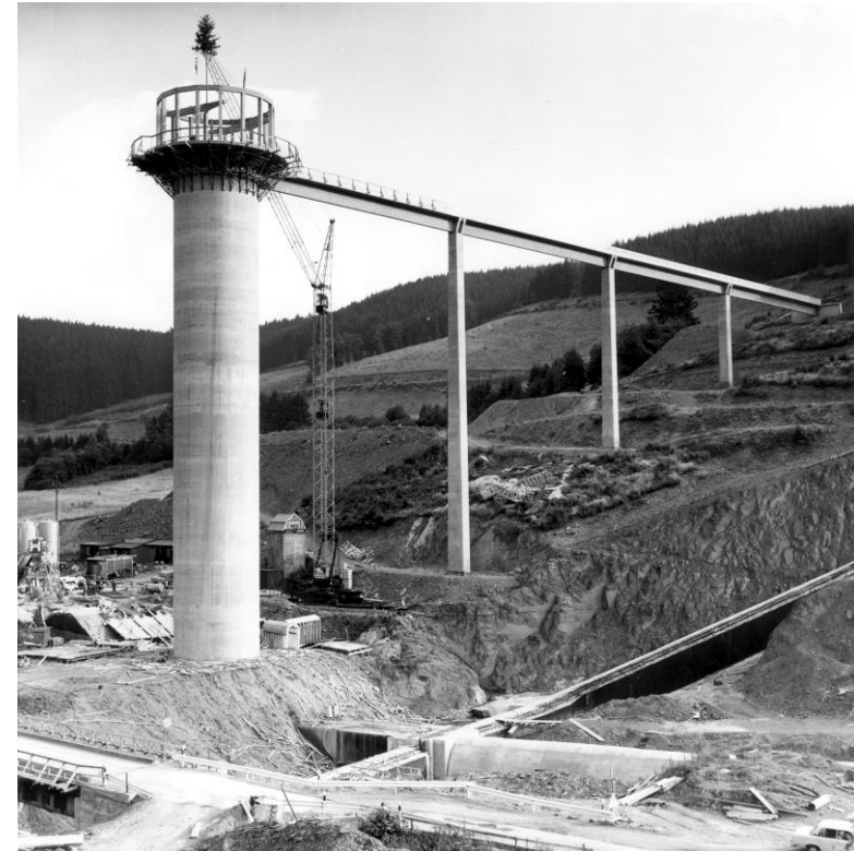
Bau der Obernautalsperre (1969)
