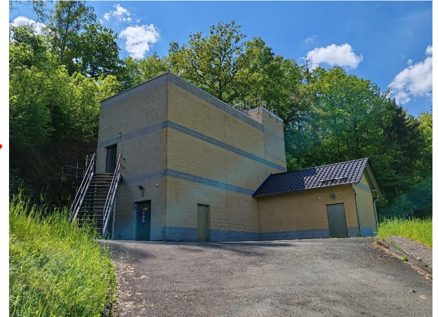
Neue Aufbereitungsanlage Vereinigte Henriette
