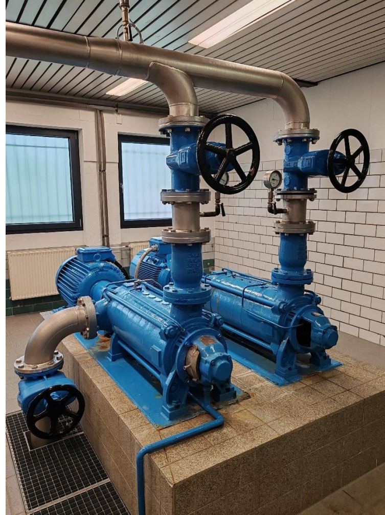
Reinwasserpumpen (Maschinenraum)
