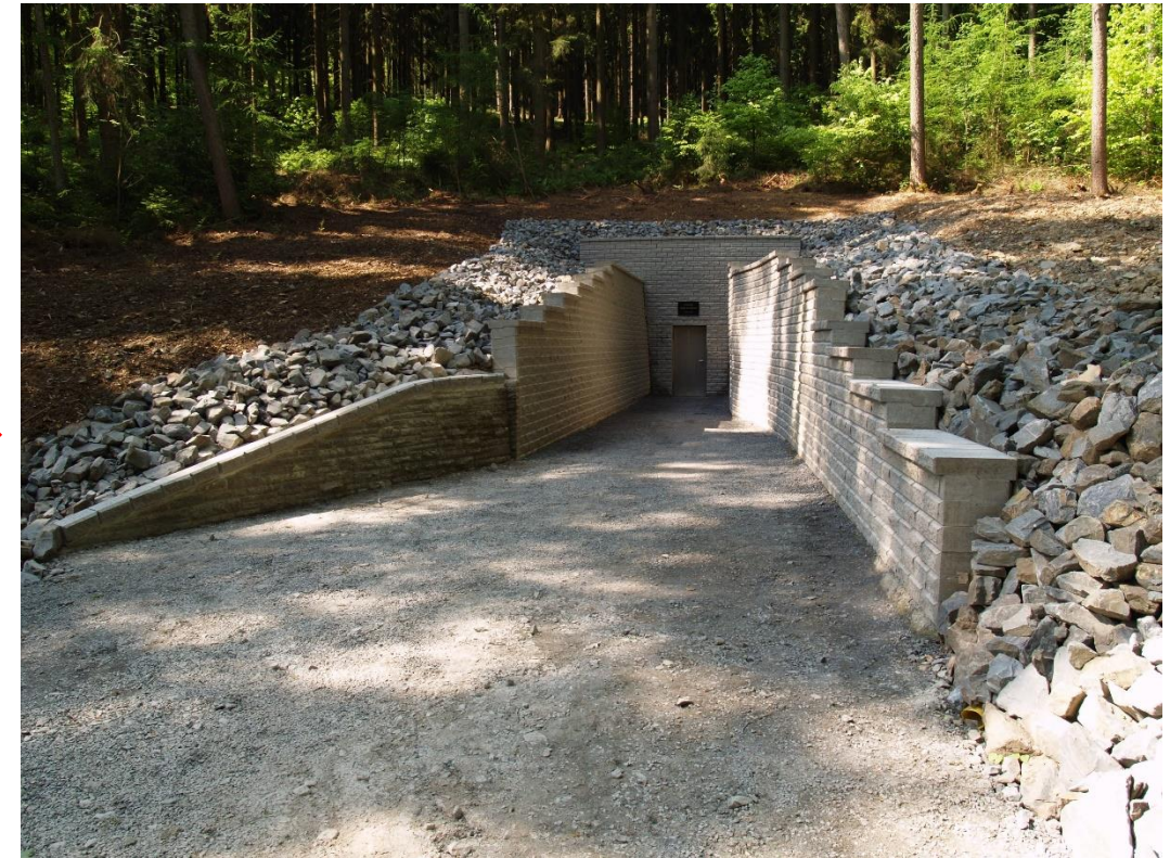
Bergwerk Vereinigte Henriette, Stollenportal Hohe Aussicht nach der Sanierung
