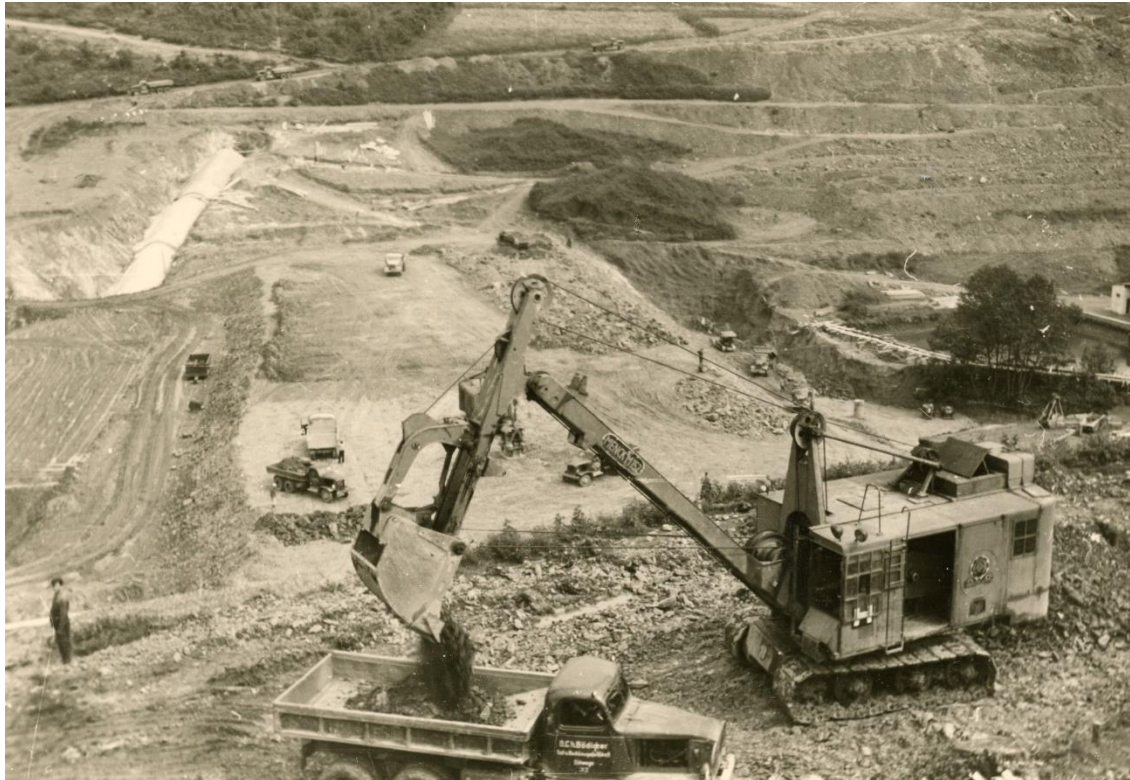
Bau der Breitenbachtalsperre (um 1953)
